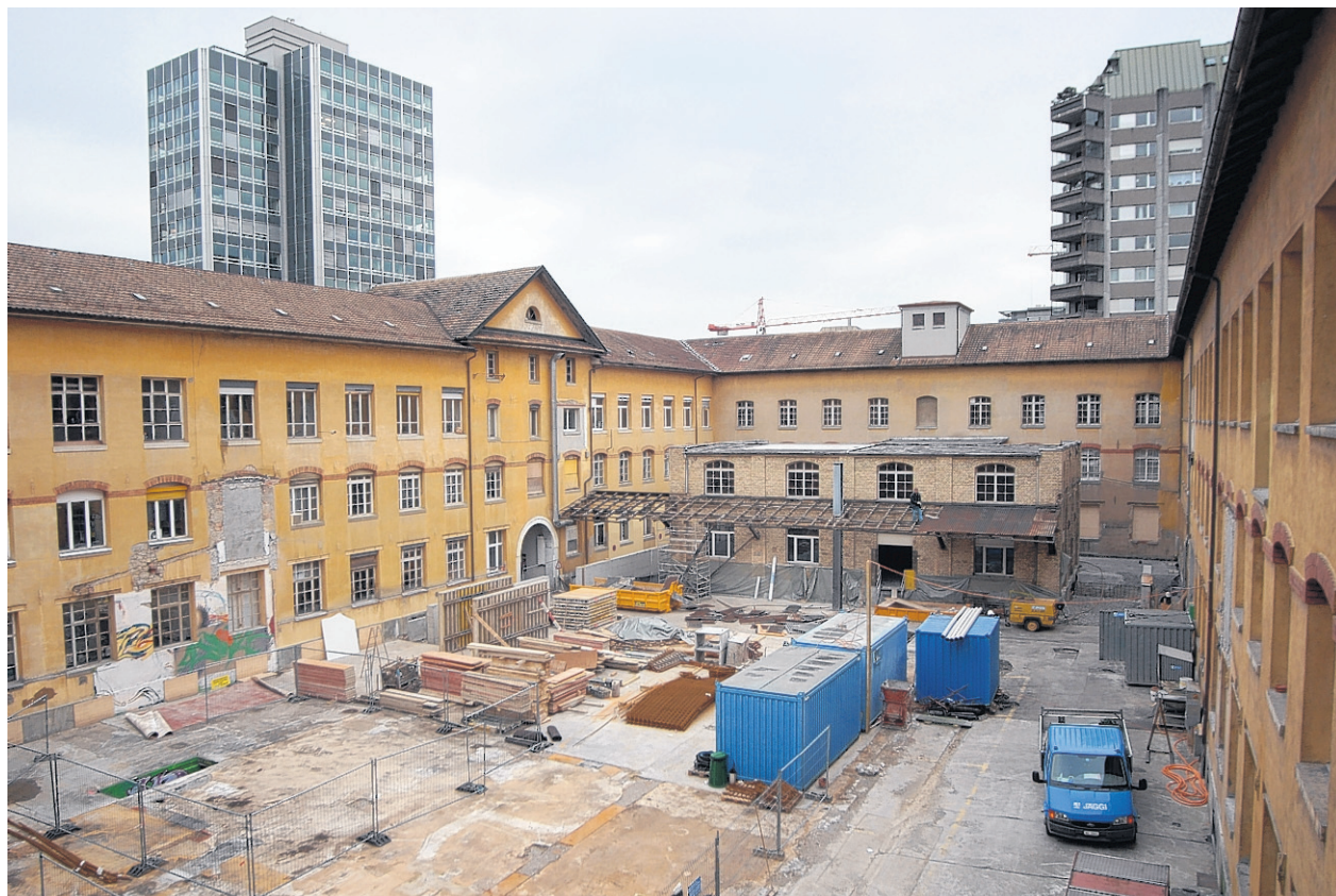
Der Innenhof wird zum Begegnungsort und mit dem Inselbau (hinten) als Kulturbox zu einer kulturellen Plattform. WALTER SCHWAGER
